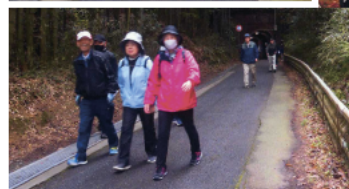
相坂トンネル
